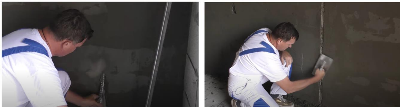
Рис. 25. Схема демонтажа маяков и заделки образовавшихся борозд
